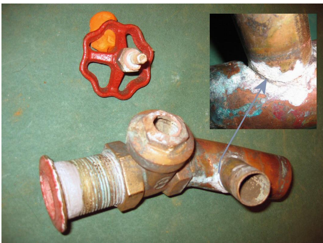
Figur nr. 2 Afzinket og knækket søventil, samt revnet messingstuds (spændingskorrosion) fra cockpitafløb.
